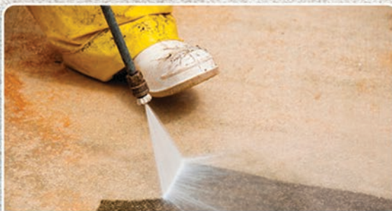
NETTOYAGE À HAUTE PRESSION
